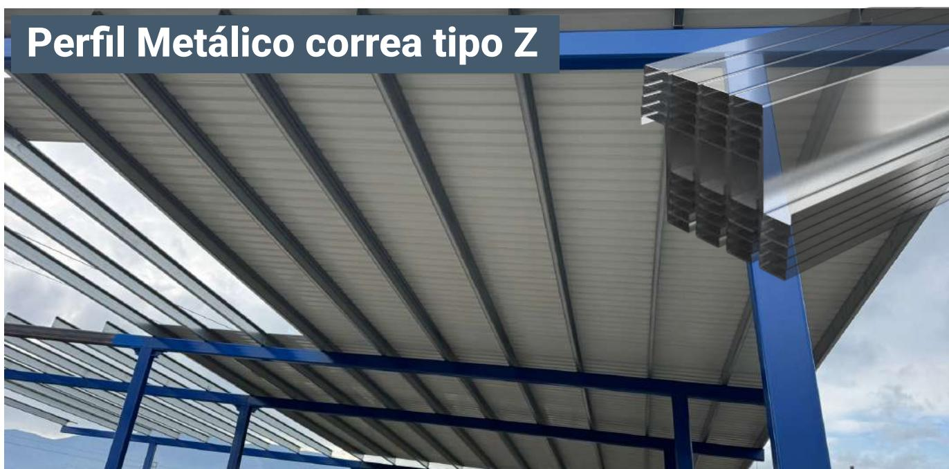
Perfil metálico de sección transversal en "Z", ideal para aplicaciones estructurales por su combinación de resistencia, ligereza y versatilidad.
